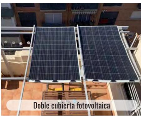
Doble cubierta fotovoltaica
