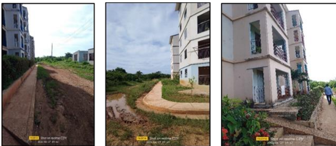
Figura 30. Urbanización de Ramón Domínguez de la Peña terminado Fuente: INOTU Ciego de Ávila, 2023
