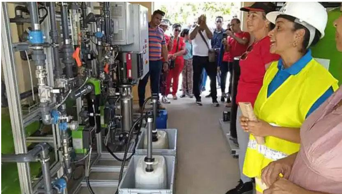
Foto 15. Instalación de equipos de bombeo con energía solar fotovoltaica Fuente: ACN
