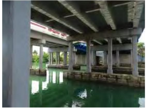
Es necesario significar que todavía persisten los problemas causados por la construcción de la Exclusa en el Canal de Paso Malo al Sur de este puente, lo que provoca el aumento de las corrientes de agua y trae consigo que se produzcan accidentes de embarcaciones contra las columnas del puente. Se deberá estudiar la eliminación inmediata de la misma ya que no se realizará extracción de petróleo en la bahía de Cárdenas.
