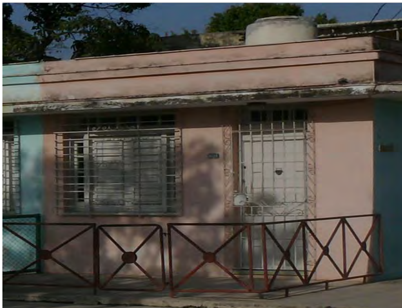
Puertas y ventanas con balaustres
