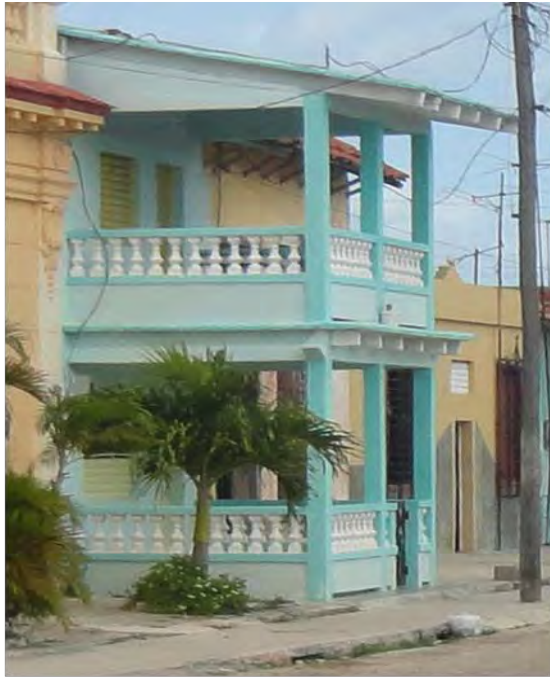
Edificación de con cercados y planchetas en e cubiert
