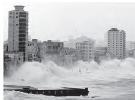
Figura 4-C. Vulnerabilidad por penetración del mar: el Malecón habanero.
