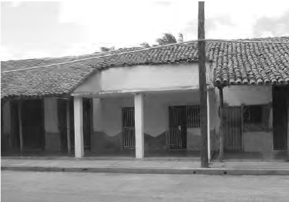
Foto 12. Ruptura de la continuidad en los techos.
