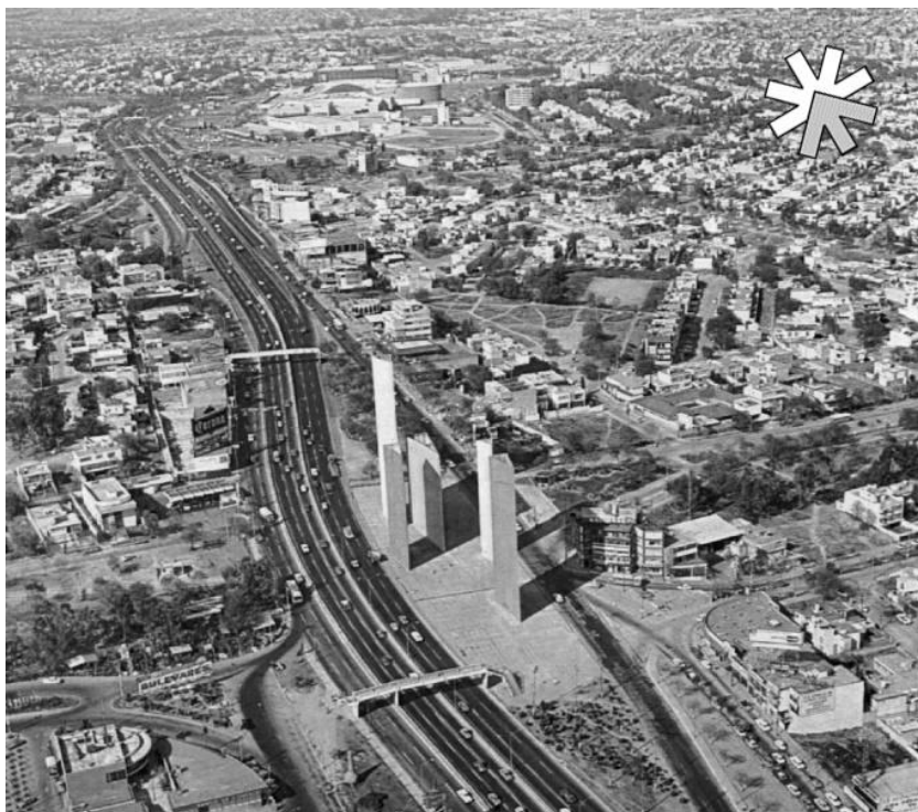
Lámina # 47, Vista parcial y torres de acceso a Ciudad Satélite.
