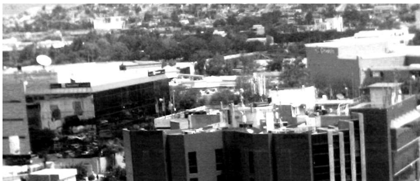
Lámina # 39.- Centros de comunicaciones inalámbricas. Las antenas de telecomunicaciones en estos edificios, muestran que la economía en la era de la información, se genera en las azoteas de los edificios altos de las ciudades.
