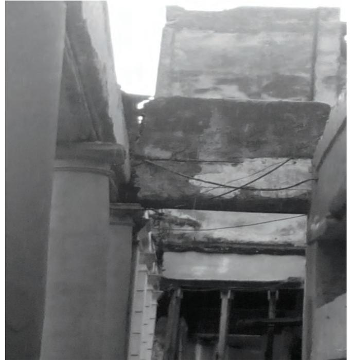
Figura 5. Vigas fracturadas en áreas públicas, calle Villegas No. 58.
