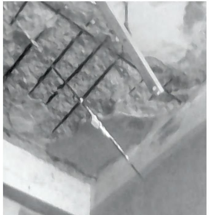
Figura 6. Desprendimientos del acero en losa de hormigón, calle Monte.
