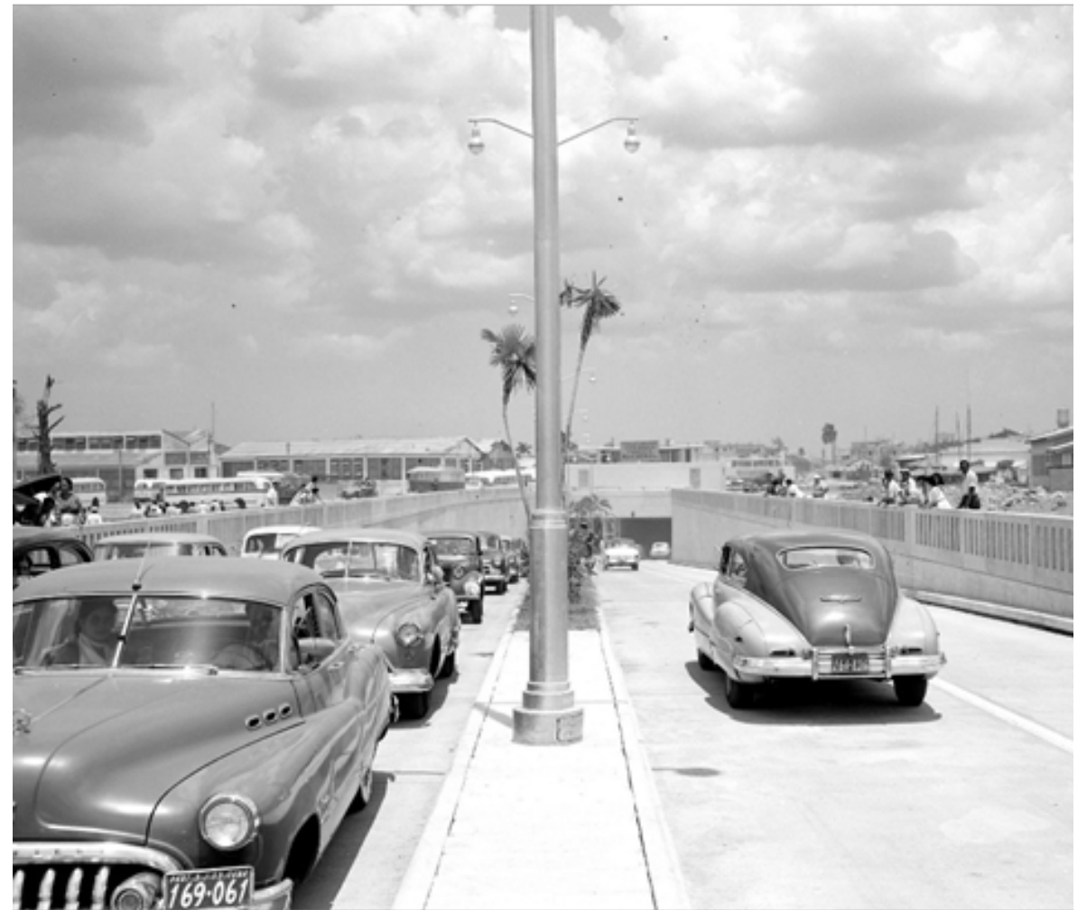
Túnel de la calle Línea. Fototeca de la Secretaría de Obras Públicas
