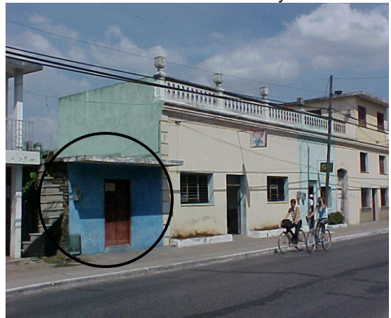
Acceso al parque interior desde la carretera Central. Instalación a demoler
