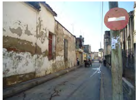
Vías y aceras estrechas en regular estado técnico que dificultan el tránsito vehicular y peatonal. Fuente Autora
