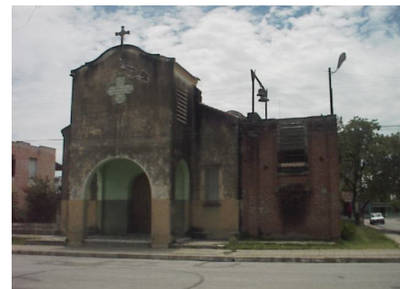
Iglesia católica con reparación/restauración. Fuente Autora
