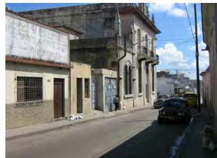
Modificaciones de fachadas, transformación de carpintería, pérdida de puntales típicos del perfil urbano. Fuente Archivo IPF
