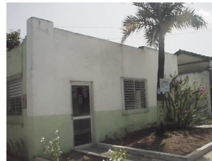
Almacén de gas licuado. Fuente Autora
