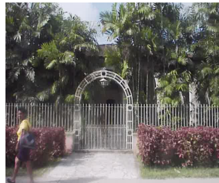
Vivienda en Constitución, esquina Máximo Gómez. Fuente Autora
