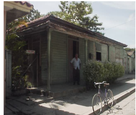
Instalaciones a demoler en Máximo Gómez. Fuente Autora
