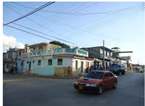
Transformaciones no adecuadas de los inmuebles, en ocasiones sin autorización. Fuente Autora
