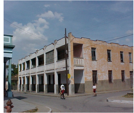
Instalación a restaurar. Escuela Antonio Maceo. Fuente Autora
