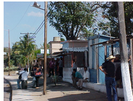
Quioscos de mal diseño que han ido ocupando el área por la carretera central. Fuente Autora
