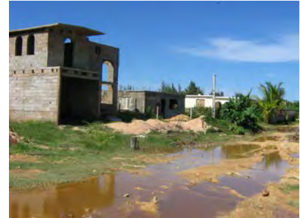
Déficit de infraestructuras técnicas. Fuente Archivo IPF
