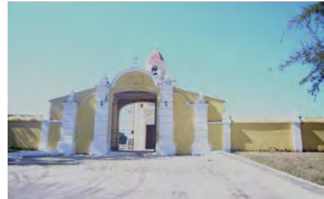
Entrada de cementerio católico de la ciudad. Fuente Autora
