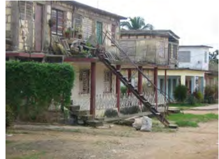
Deficiente control del territorio, escaleras en áreas de jardín y ocupando el espacio público. Fuente Archivo IPF
