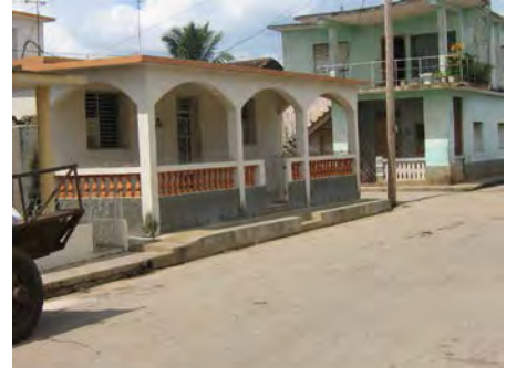
Tecnologías, materiales y elementos inadecuados que nada tienen que ver con la identidad local. Fuente Archivo IPF
