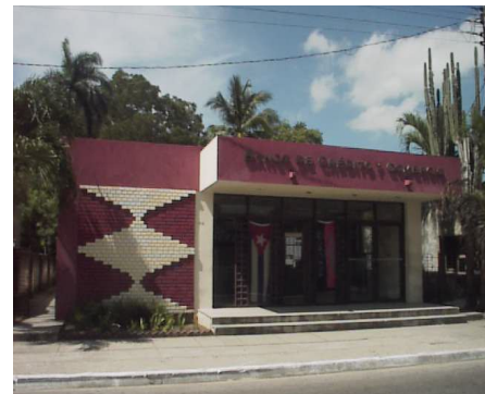
Instalación a rediseñar. Banco Nacional. Fuente Autora
