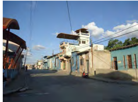
Desconocimiento por los gobernantes y la población de las buenas prácticas en materia de arquitectura y urbanismo. Fuente Autora
