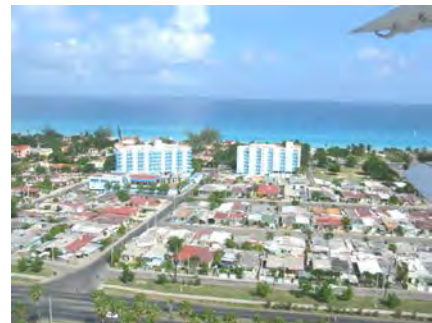
Desaprovechamiento del suelo urbano, bajas densidades en suelos de altísimo valor. Fuente Archivo DPPF Matanzas
