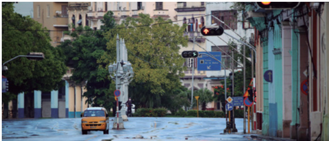
Imagen 1. Barrio Habanero con elevada vulnerabilidad a la COVID-19.
