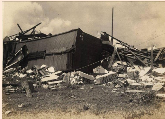
Terminal Trenes zona de Reina después huracán. 1935
