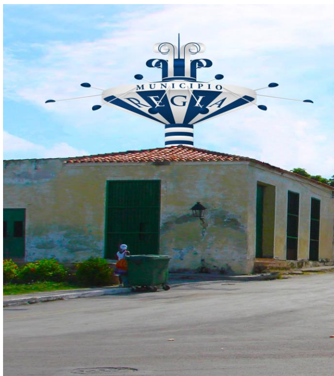
Intersección de las Calles Máximo Gómez y Santuario
