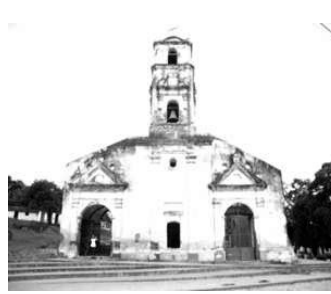
Iglesia con alto grado de deterioro cerca de Las Cuevas.
